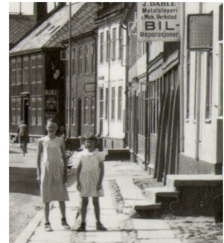
Brit og Gerd utenfor Nygata 26/28 på Bakklandet. Aslaug drev frisørsalong opp trappen til høyre, i 'litj-stua.'
