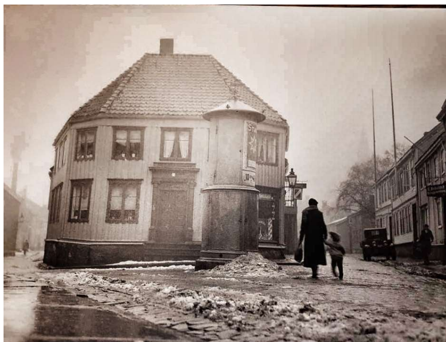
Nedre Bakklandet 27. Her deler gata seg. Nedre Bakklandet fortsetter ned mot høyre. Nygata fortsetter mot venstre. Nygata 4 er på venstre side av bildet, Knut Hernes ble påkjørt ved søyla midt i bildet; her var det en drosjesjåfør som ikke klarte å stoppe i tide. Kvinnen og barnet i bildet vet vi ikke navnet på. Kanskje er det Aslaug og Knut?
